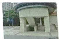
H 秀榮大樓入地下室樓梯
