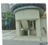
H 秀榮大樓地下室樓梯
